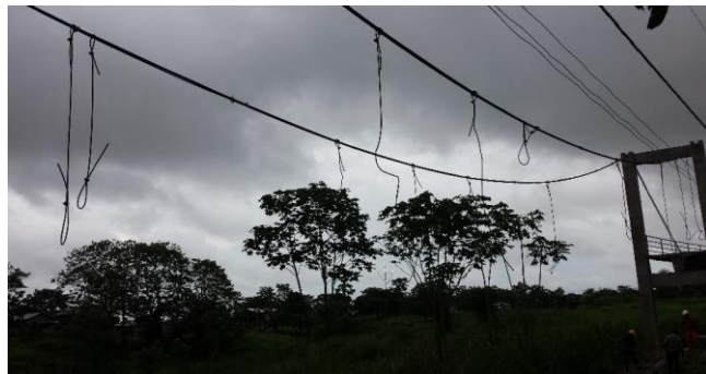
Foto 13: Colapso del Puente N° 1
