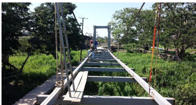
Foto 5: Montaje cables y estructura metálica Puente N° 1
