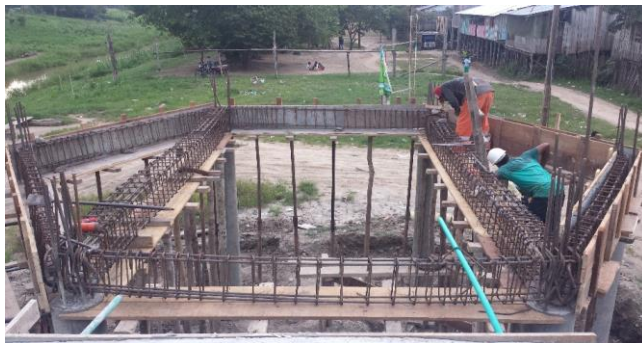
Foto 8: Vigas Aéreas mirador N° 3 - K0+500
