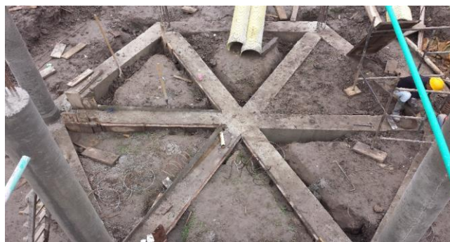
Foto 2: Vigas de cimentación mirador N° 3 - K0+500
