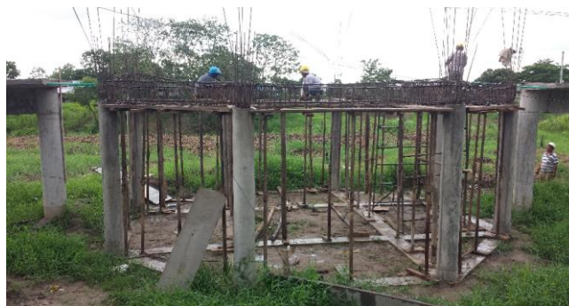
Foto 4: Refuerzo vigas aéreas mirador N° 1 - K0 + 170
